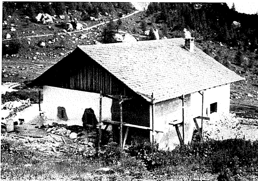
Il Rifugio "Città di Fiume" nel corso dei lavori (foto P. Dalmartello)
