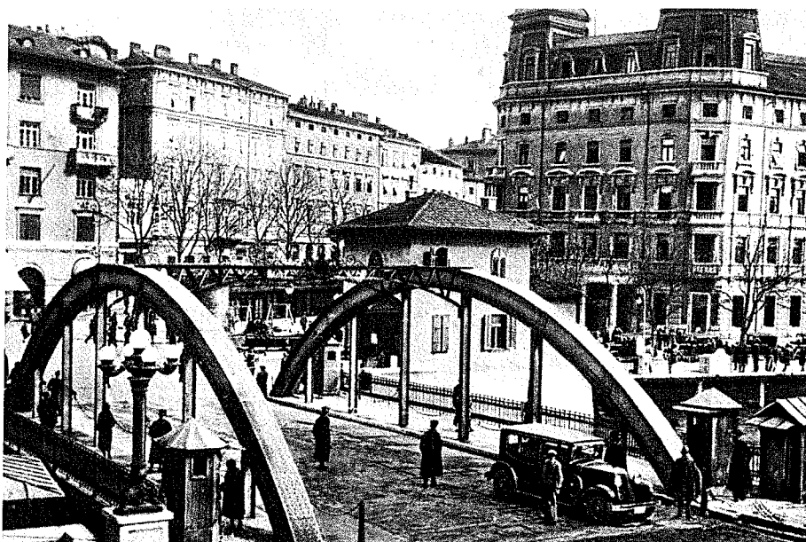
Fiume - Il ponte sull'ex confine italo-jugoslavo.
